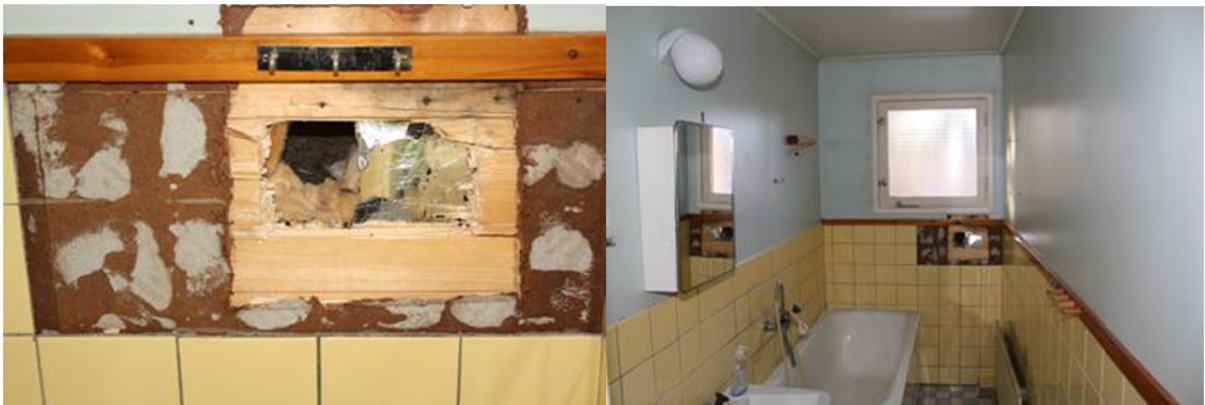
Figur 16. Håltagning i badrumsyttervägg, inget synligt mögel påträffades.
