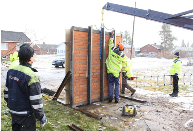
Figur 24. Väggen utlyft och fäst i vaggan.
