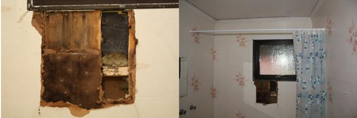
Figur 15. Håltagning i badrumsyttervägg , synligt mögel påträffades.
