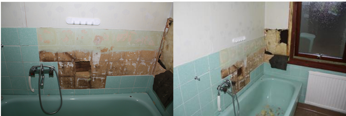
Figur 17. Håltagning i badrumsyttervägg samt mellanvägg, synligt mögel påträffades i båda väggarna.
