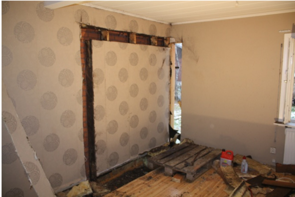
Figur 21. Frilagt runt väggelementets insida.
