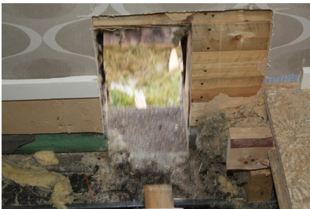
Figur 20. Undersökning och materialprovtagning i träfasadhuset.
