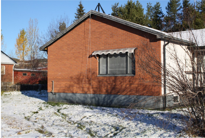
Figur 1. Byggnaden med skaltegelfasad innan uttag av vägg. Fasadriktning är sydsydväst.
