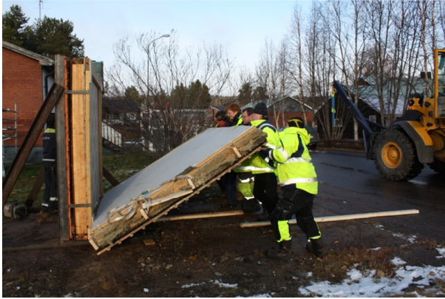
Figur 25. Träfasadsväggen lyfts på plats på vaggan.
