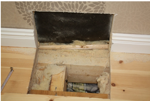
Figur 19. Undersökning och materialprovtagning i skaltegelhuset.
