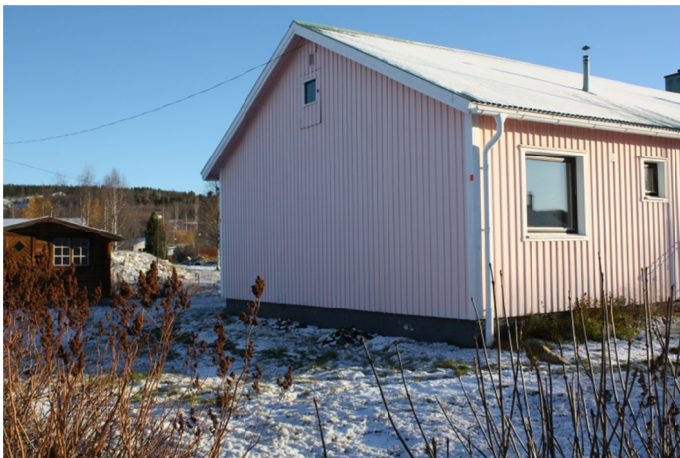
Figur 2. Byggnaden med träfasad innan uttag av vägg. Fasadriktningen är västnordväst
